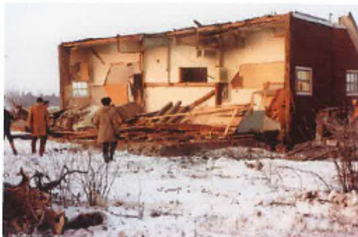
Bohman's röda boningshus, Ökna, i samband med rivningen.
