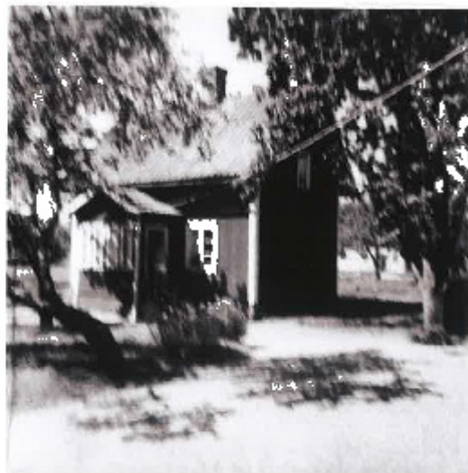
Fridenslund, rött hus, där Ivar Andersson bodde, Ökna
