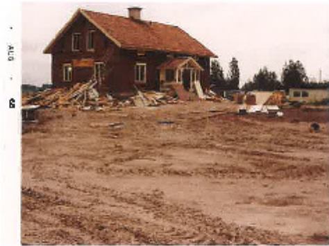
Bertil Johansson's röda boningshus. Ökna, i samband med rivningen.
