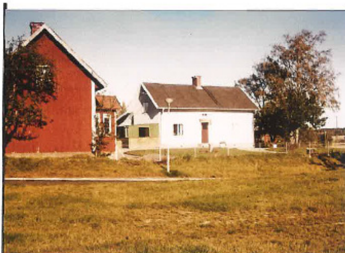
Fridenslund, rött hus, där Tygr Andersson bodde, Ökna. Stod på området där Forward hade sin klubbstuga. Klubbstugan var i det vita huset, klätt med plattor. Troligen gult eller vitt från början. Familjen Sven Andersson bodde där. Garage och förråd idag. Gränsar mot Landby.
