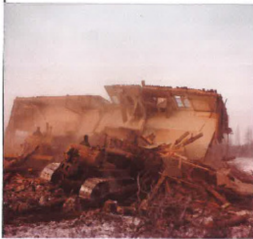
Bohmans röda böningshus, Ökna, i samband med rivningen.
